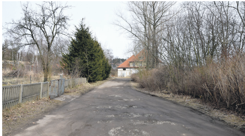
Ulica Królowej Jadwigi zostanie przebudowana.
