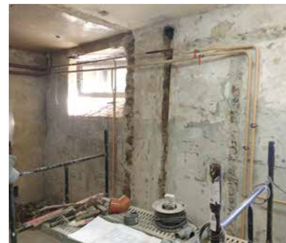
Remont szkolnych toalet.
