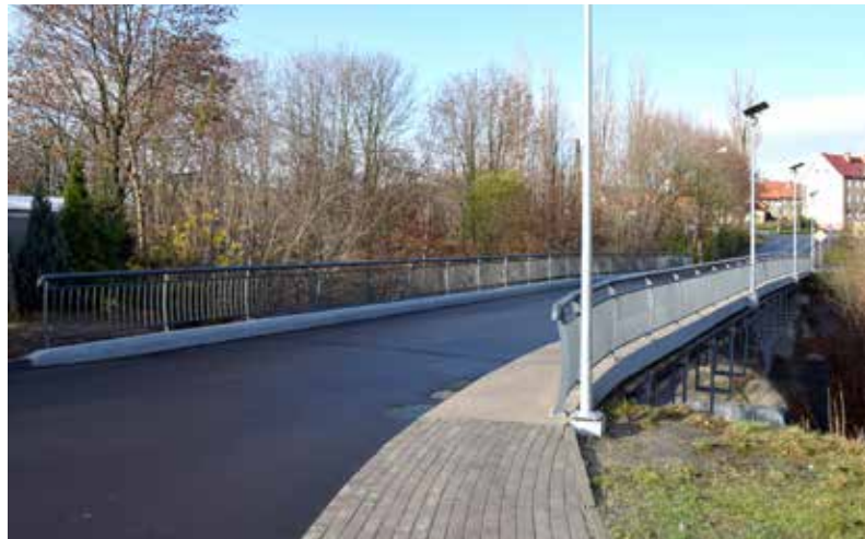
Wiadukt na ul. Krakowskiej po remoncie.
