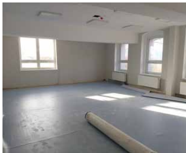
Trwają prace budowlane w przyszłym przedszkolu.
